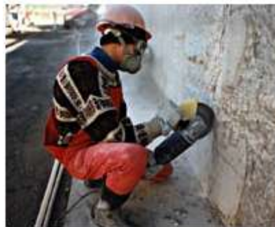
A látható repedések kimarása a Penetron felhordása előtt
