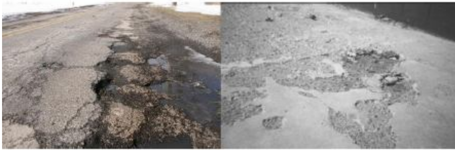
9. Ábra: Példa az útfelületek és híd pályák fagyási-olvadási ciklus okozta károsodására
