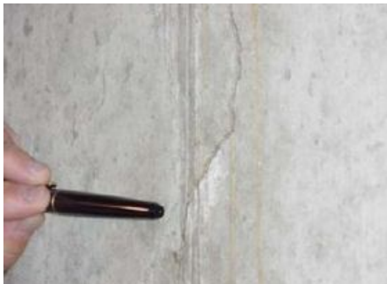
2. Ábra: Példa a képlékeny zsugorodási repedésre
