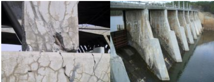
8. Ábra: Példa az ASR reakció okozta károsodásra
