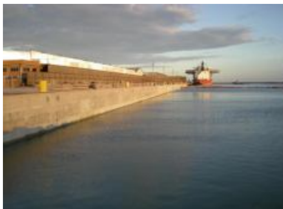
19. Ábra: Penetron Admix-szel kezelt partvédő fal, Portocel, Aracruz, Brazília
